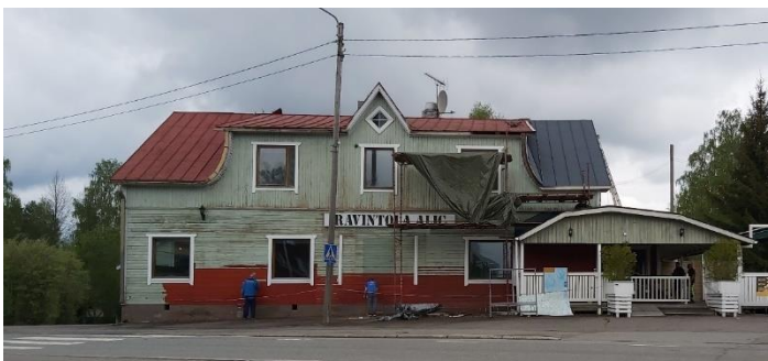
Kuva 59 Rakennuksen kunnostusta, julkisivut ja vesikatto uudistetaan.
