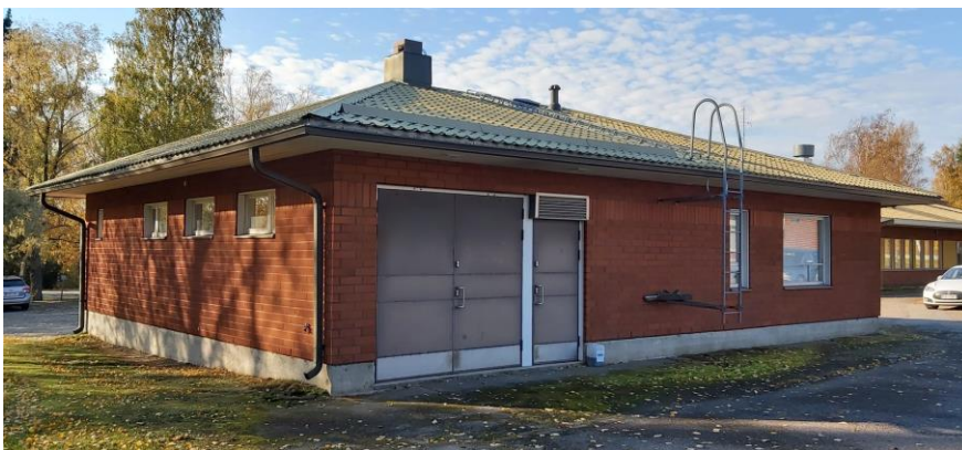
Kuvat 51 ja 52 Julkisivut entisen terveysaseman kiinteistöllä sijaitsevasta rakennuksesta, joka vastaa piirteiltään entistä terveysasemaa.
