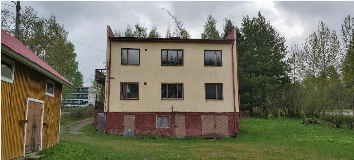
Kuva 20 Keskustie 56:n julkisivu länteen pihan suuntaan.
