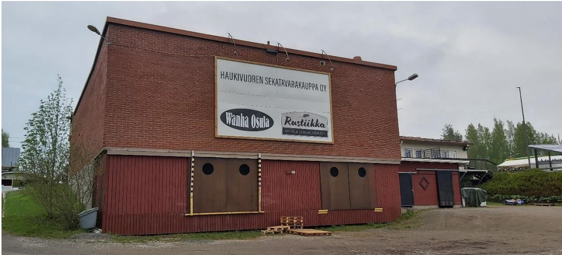
Kuva 63 Rakennuksen julkisivua länteen sisäpihan ja Pieksämäentien suuntaan.
