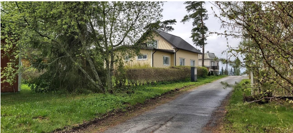
Kuva 71 Oikotein kujanne on pienimittakaavainen puutalomiljö Keskustien aukion reunalta itään päin. Kuvassa kujannetta kuvattuna länteen. Oikotie päättyy aukiolle ja Keskustiehen jota rajaa taustalla näkyvä entinen Säästöpankin talo.
