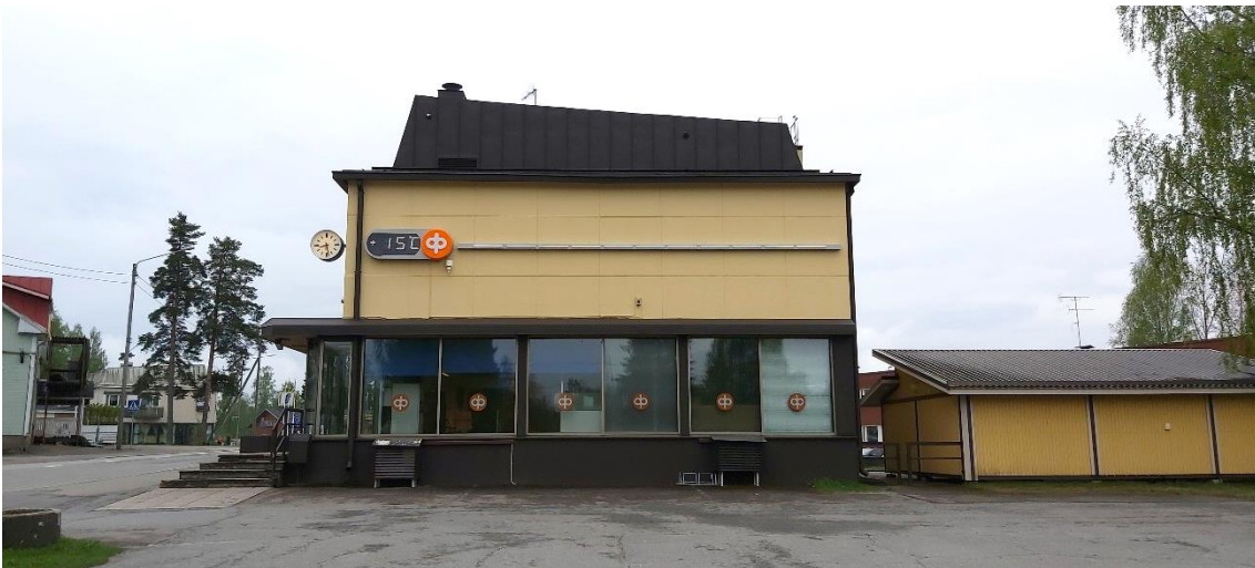
Kuva 7 Osuuskassan liiketalon julkisivu pohjoiseen pysäköintialueen ja Haukivuorentien suuntaan. Kuvassa myös piharakennusta.
