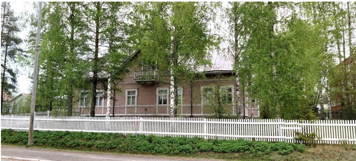
Kuva 14 Rakennuksen pääjulkisivu länteen Keskustien suuntaan peittyä kesäaikaan vehreiden koivujen taakse.
