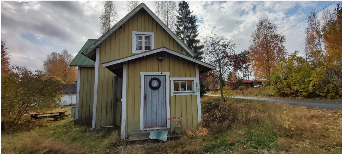
Kuva 106 Rakennuksen sisäänkäynti ja julkisivu pohjoiseen.
