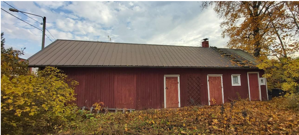
Kuva 103 Piharakennuksen julkisivu länteen pihan suuntaan. Rakennus rajaa kiinteistöä sen itälaidalla muodostaen suojaisaa pihapiiriä. Haastattelutiedon mukaan rakennuksessa on saatettu pitää hevosta.
