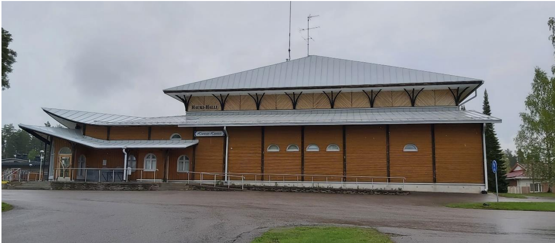
Kuva 41 Hauki-Hallin julkisivu länteen Keskustien suuntaan.
