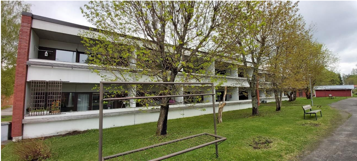
Kuva 88 Rakennuksen läntinen julkisivu, jossa sijaitsevat asuntokohtaiset parvekkeet.
