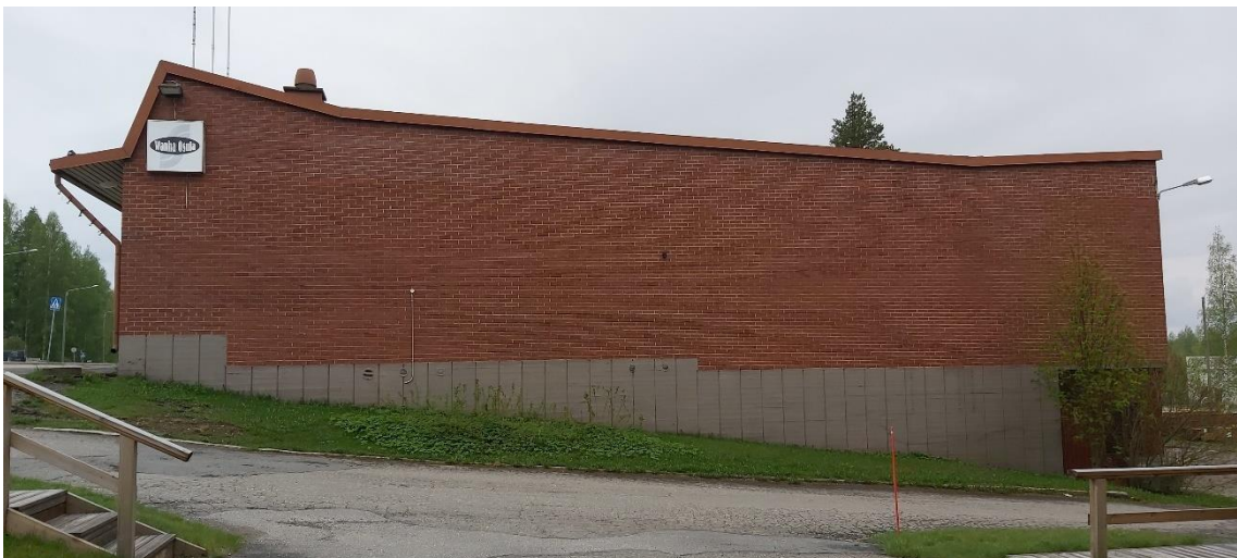
Kuva 62 Rakennuksen ikkunaton pohjoispääty, jonka edustalta on kulku sisäpihalle ja edelleen muille kiinteistöille.
