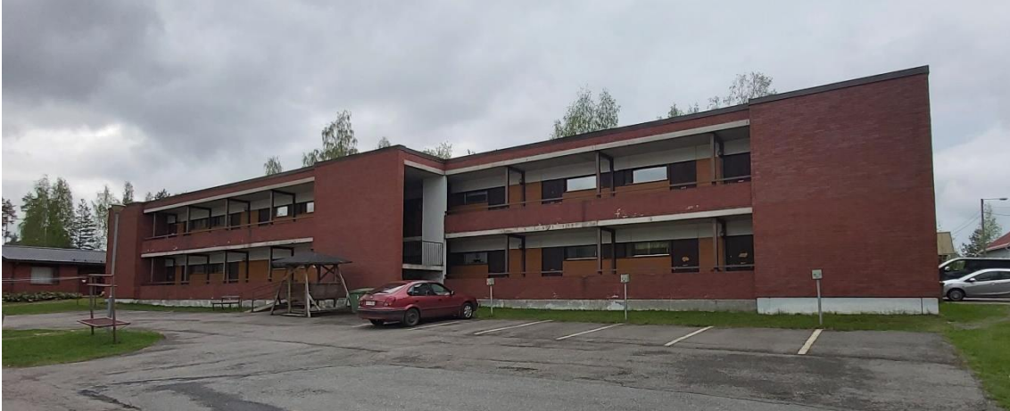
Kuva 86 Taloyhtiö Työkulman julkisivu itään Suojatien suuntaan. Horisontaalista rakennusta on rytmitetty murroksella, joka jakaa rakennuksen kahteen siipeen.
