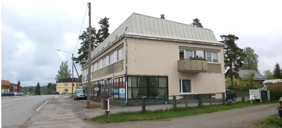
Kuva 12 Rakennuksen eteläinen julkisivu, jossa parveke.
