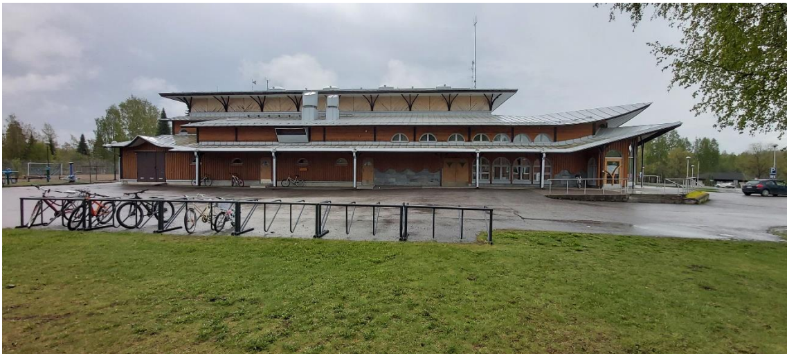
Kuva 42 Hauki-Hallin julkisivu pohjoiseen koulun ja tosin suuntaan. Pääsisäänkäynti sijoittuu rakennuksen luoteiskulmaan.
