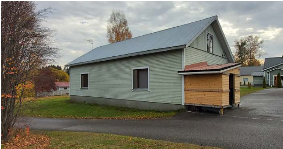
Kuva 58 Talousrakennuksen julkisivua pohjoiseen ja länteen.
