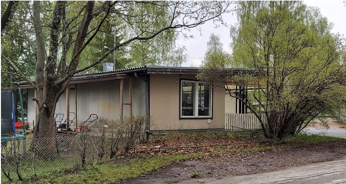
Kuva 79 Rakennuksen julkisivu länteen Keskustien suuntaan sekä sisäpihan puoleinen julkisivu pohjoiseen.
