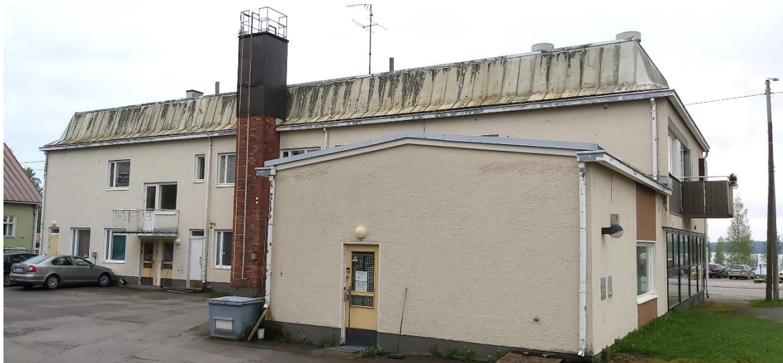
Kuva 11 Rakennuksen sisäpihan julkisivu, jossa punatiliinen hormi.
