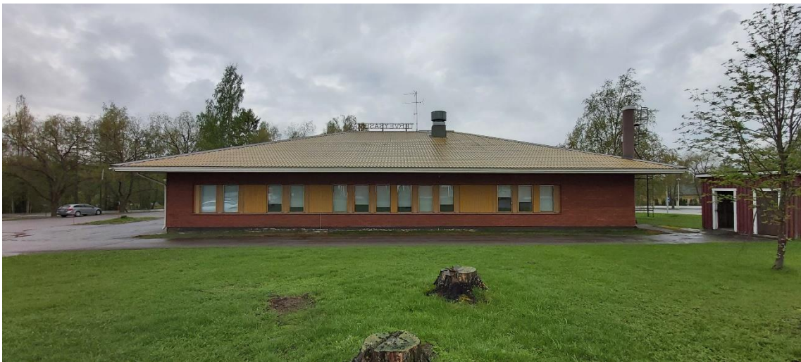
Kuva 47 Rakennuksen julkisivu itään.
