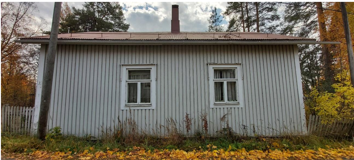
Kuva 100 Rakennuksen pääjulkisivu pohjoiseen Suojatein suuntaan.
