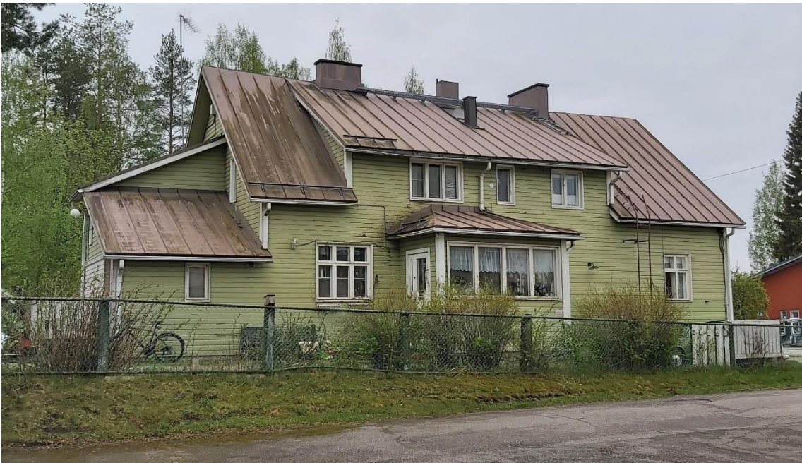
Kuva 82 Rakennuksen pohjoinen julkisivu, jossa sijaitsee rakennuksen pääsisäänkäynti.
