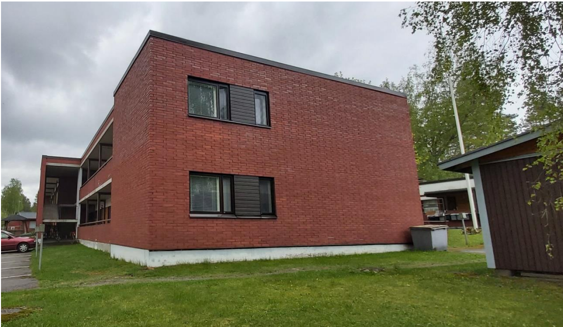
Kuva 87 Rakennuksen pohjoinen päätyjulkisivu ja murroskohta, jossa sijaitsee porrashuone.
