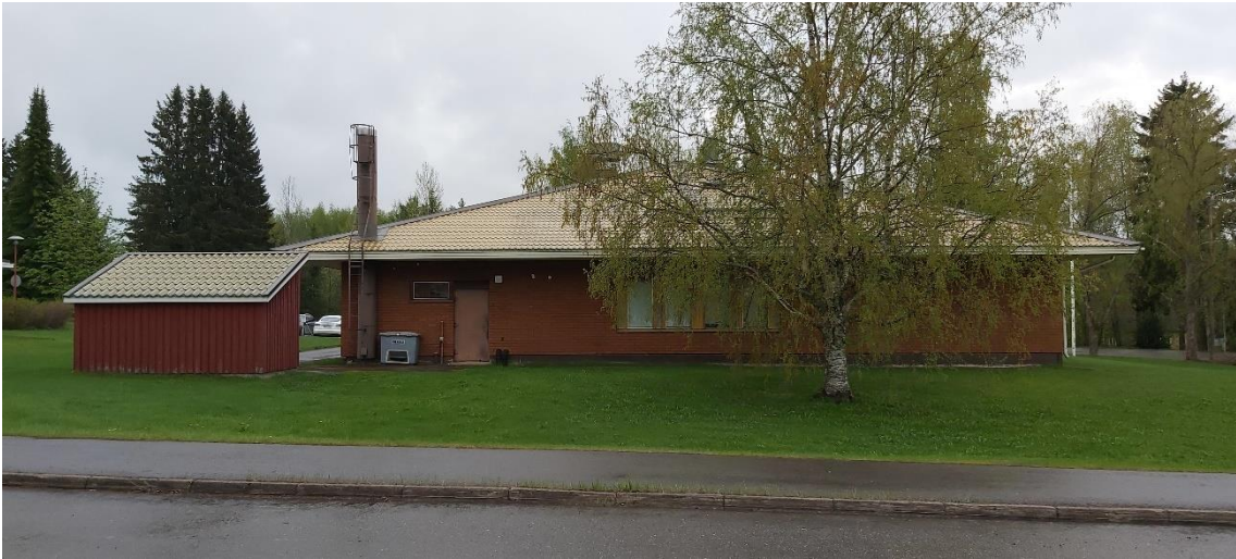
Kuva 48 Entisen terveysaseman julkisivu pohjoiseen Hauki-Hallin pysäköintialueen suuntaan.
