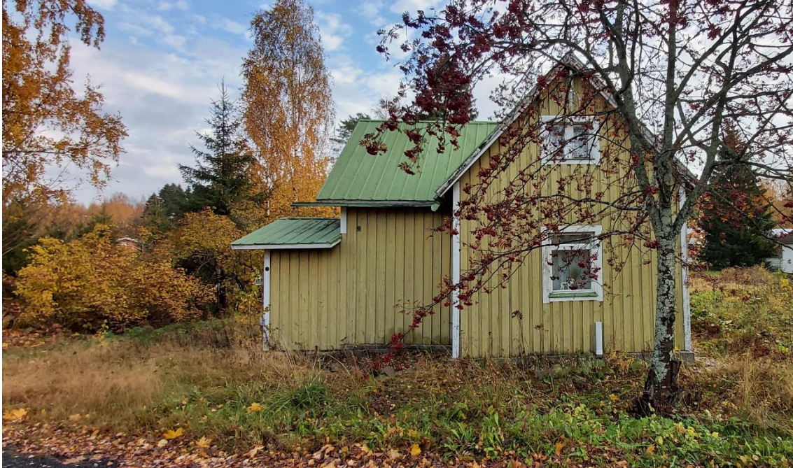
Kuva 104 Rakennuksen pääjulkisivu länteen Suojatien suuntaan.
