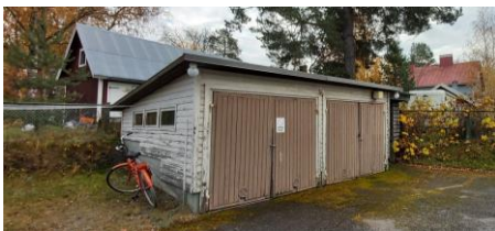
Kuva 10 Talousrakennus (1964) pohjoiseen ja länteen.
