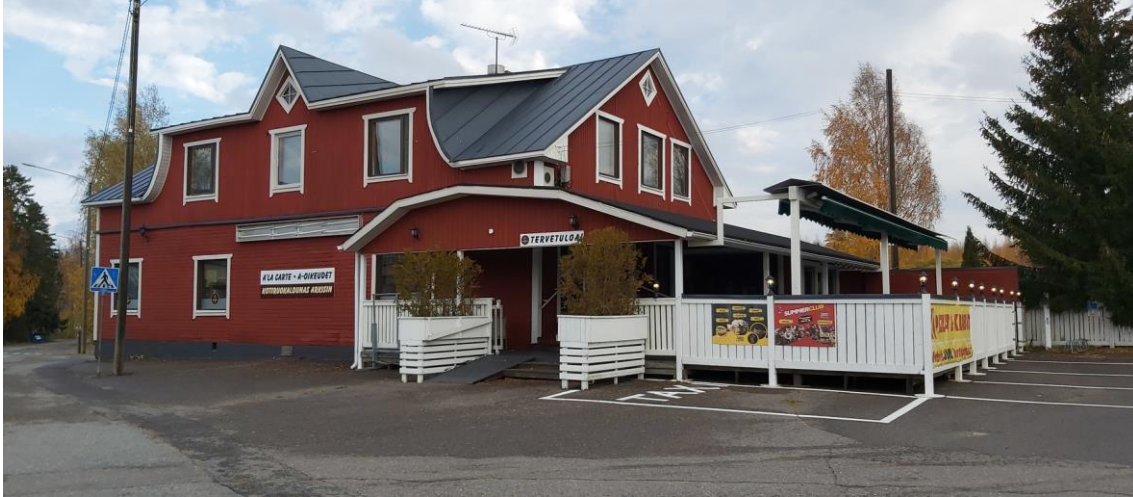
Kuva 60 Rakennus kunnostutöiden jälkeen uudessa julkisivuvärytyksessään.
